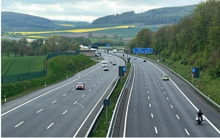
Blick auf die fertige Autobahn
