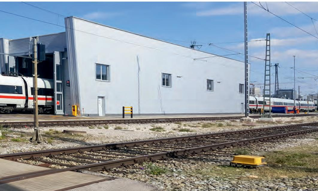
ständert durch die Halle geführt wird. Somit ist eine Begutachtung der Zugunterseiten auf der gesamten Länge möglich. Die Grundrissabmessungen der Halle betragen ca. 55,40 m x 7,95 m (l x b) bei einer Bauwerkshöhe von ca. 8,50 m (inkl. Attika 9,40 m).
