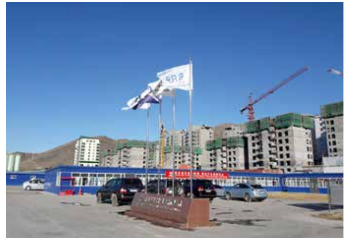
Büro- und Wohnbaracken auf dem Gelände der Feldfabrik
