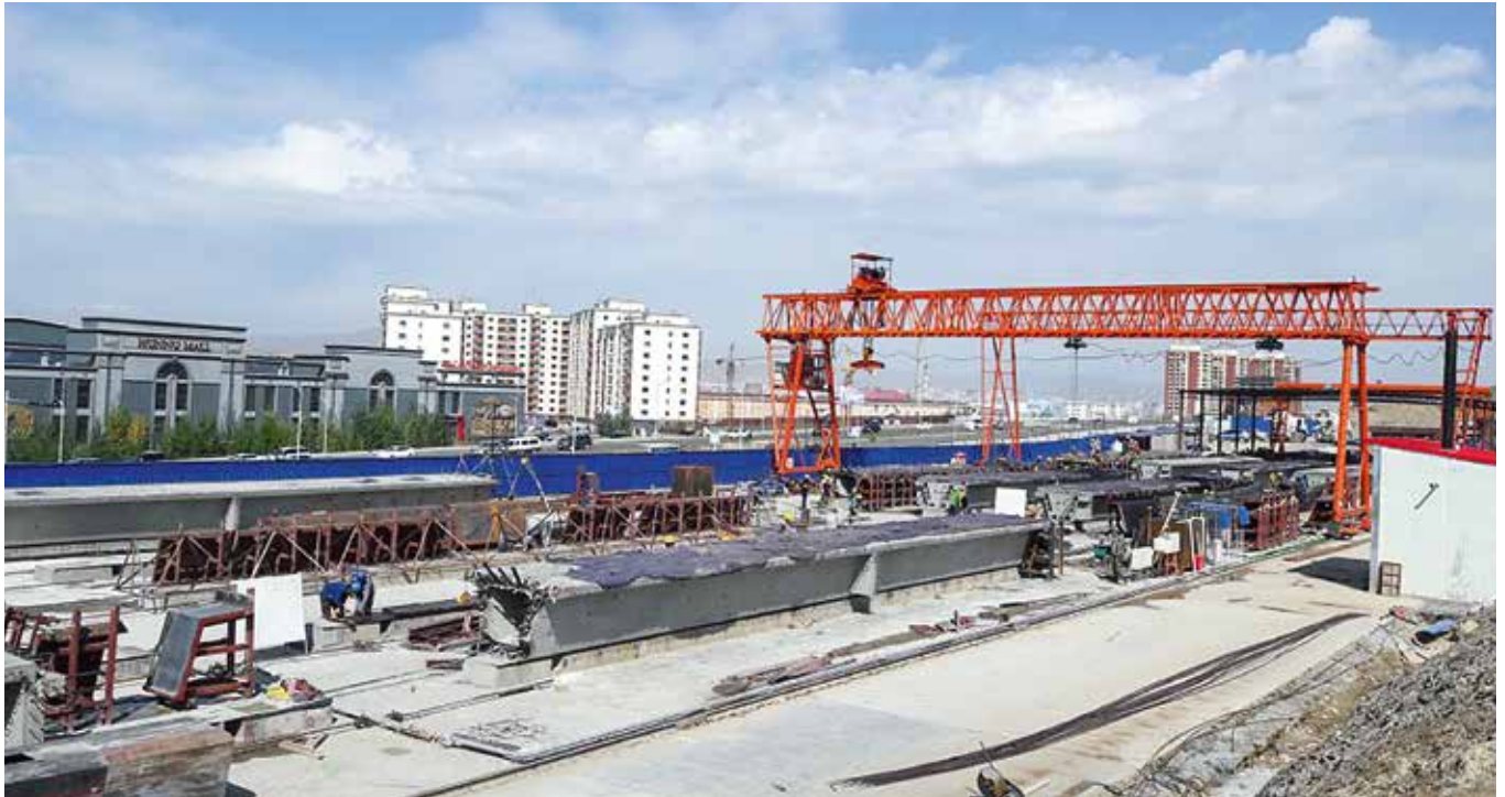
Feldfabrik für bis zu 30 m lange Spannbetonfertigteile
