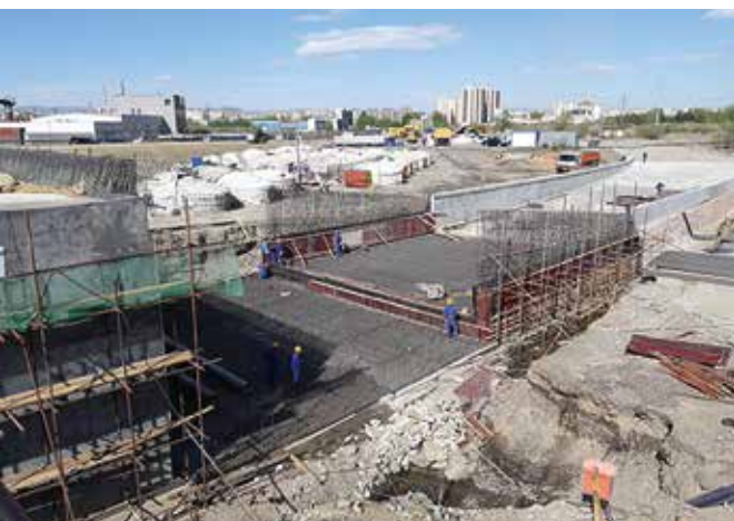
Herstellung Grundwasserwanne / Rahmenbauwerk
