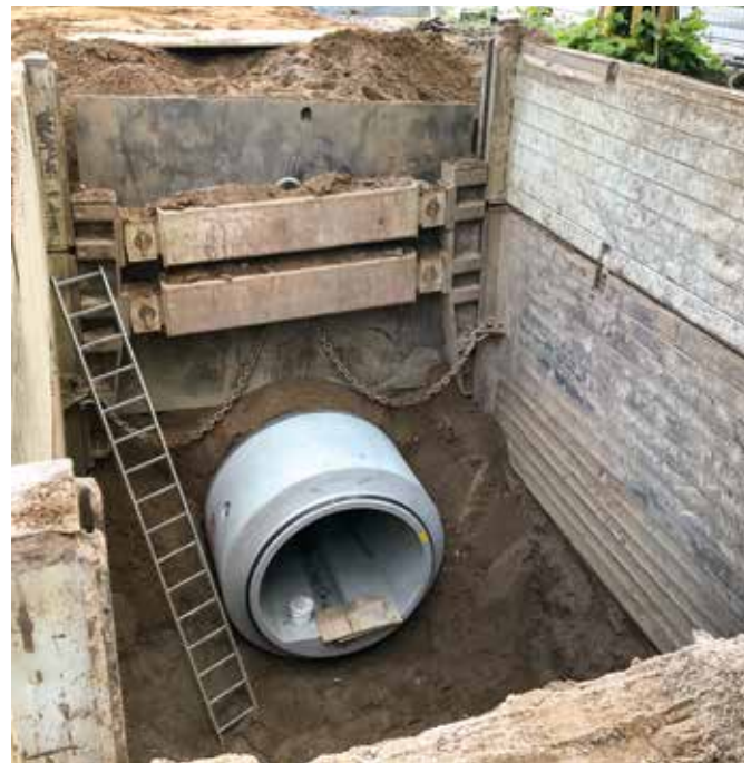
Stauraumkanal in der Baugrube
