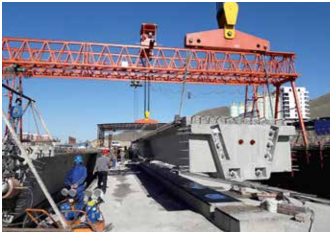
Transport eines Fertigteils zum Lagerplatz mit Hilfe von Portalkranen
