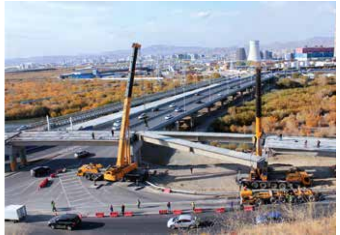
Verlegung von Fertigteilen für den Flyover durch Mobilkrane
