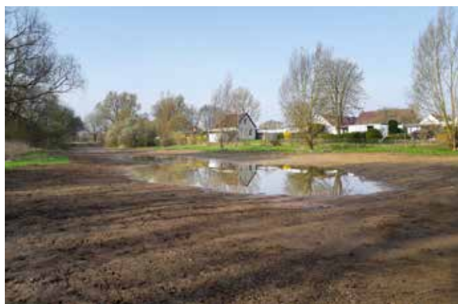
Zustand nach dem flächigen Bodenabtrag
