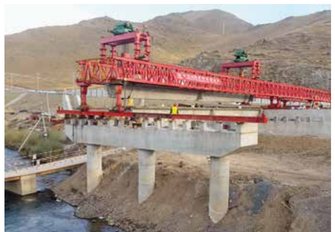
Chinesisches Fertigteilverleegerät im Einsatz auf der Hauptbrücke
