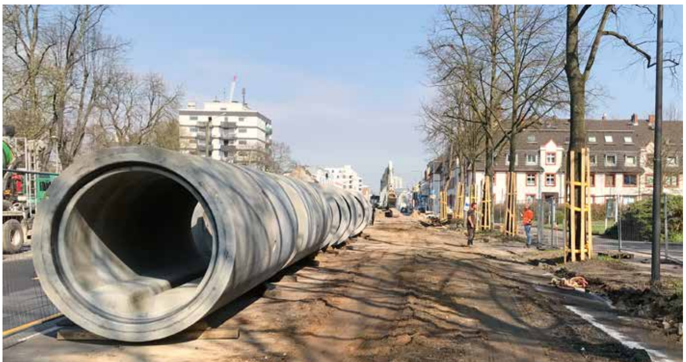
Der neue Stauraumkanal vor dem Einbau
