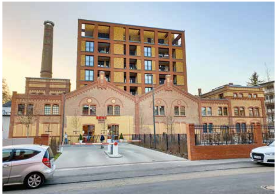
Ostfassade – Eingang Rewe-Markt
