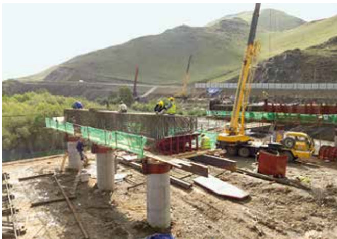
Herstellung Pfeilerquerträger der Hauptbrücke
