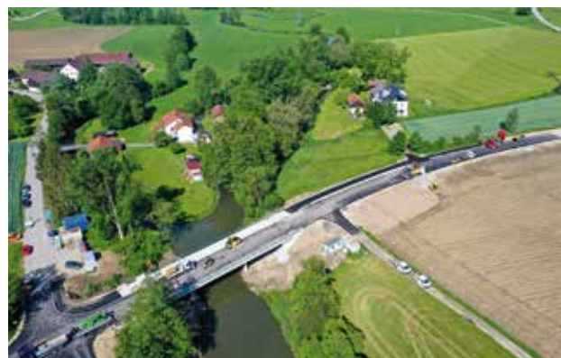
Brücke über die Kollbach bei Arnstorf
