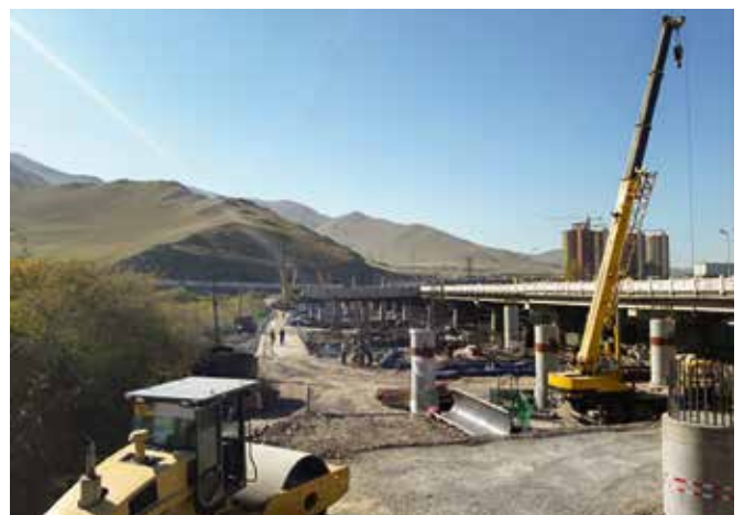
Baufeld der Hauptbrücke
