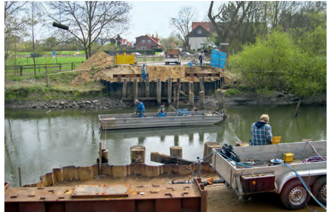
Herstellung der Behelfsbrücke
