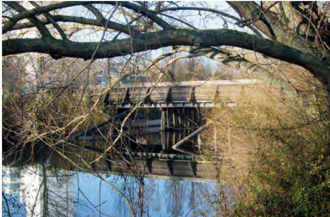
Die alte Holzbrücke
