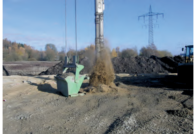
Bohrung in den Untergrund
