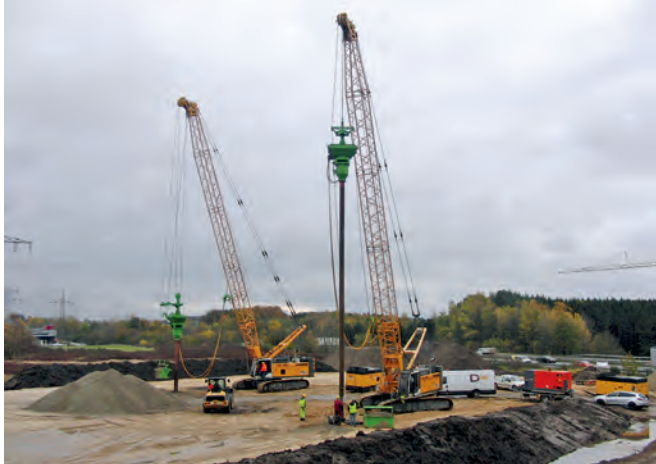
Einbringen der Rüttelstopfsäulen in den vorhandenen Boden
