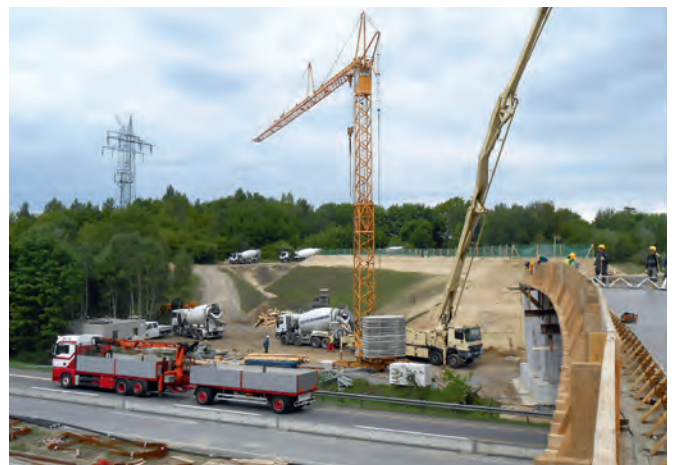
Herstellung des Brückenbauwerks über die A1
