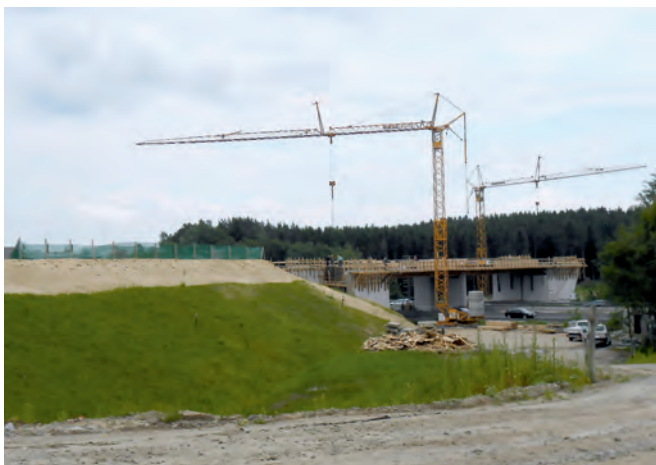
Fertiggestellter Damm mit Grünbewuchs
