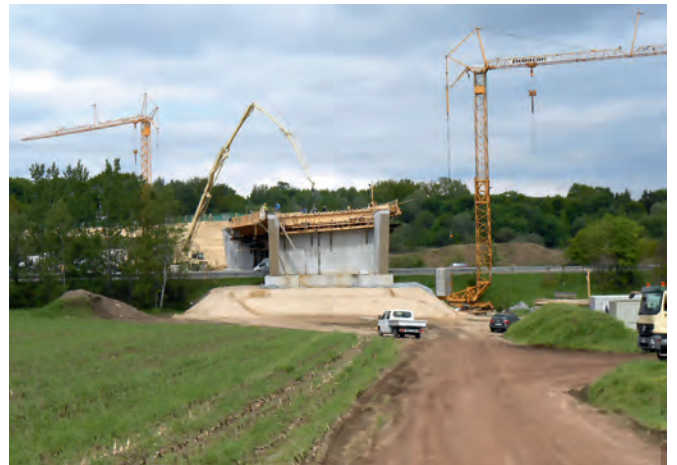
Betonage Überbau des Bauwerks 3
