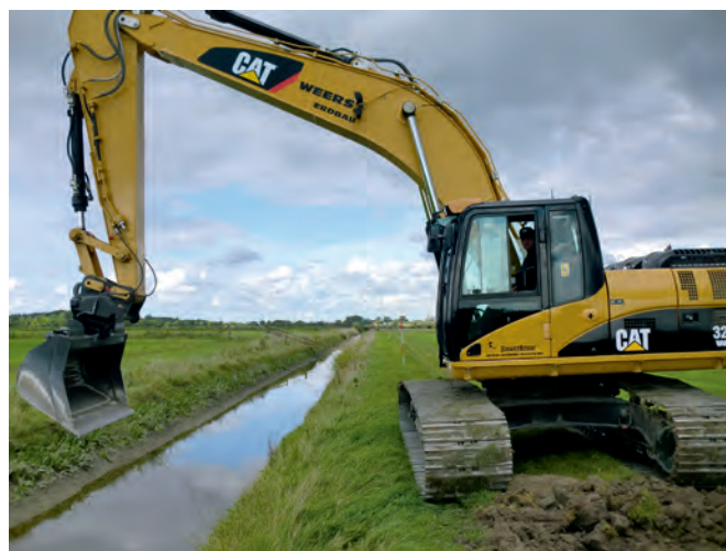
Böschungmodellierung an dem neu geschaffenen Wegenetz
