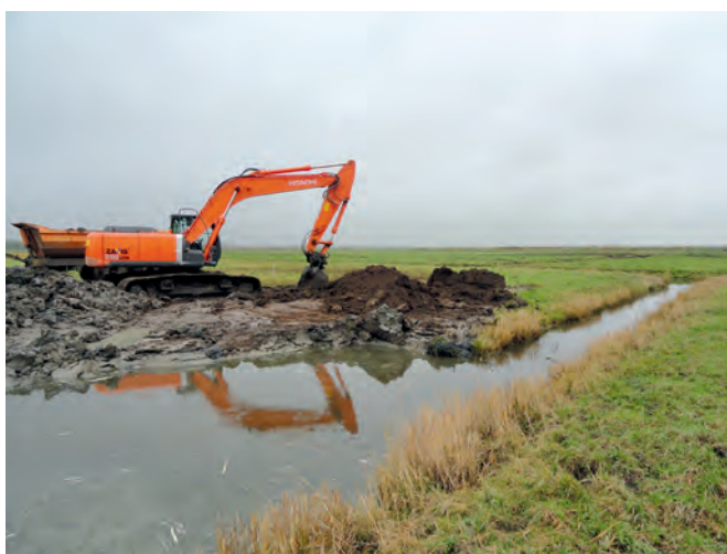
Naturnahe Grabenaufweitung
