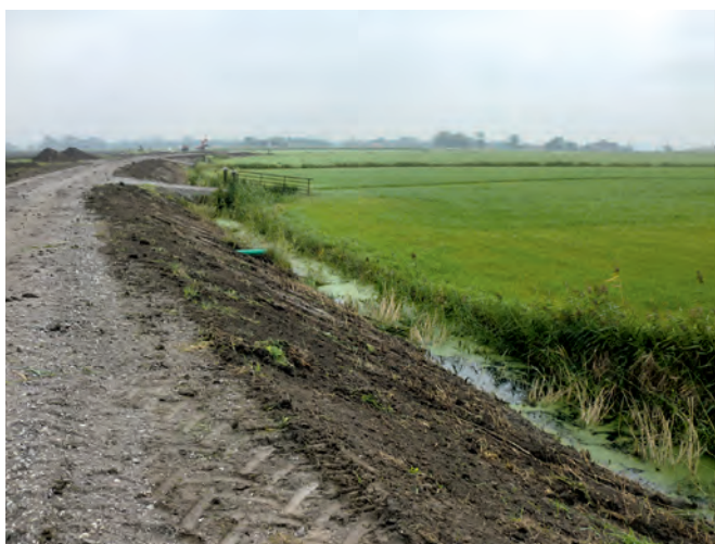
Erstellung neuer Wirtschaftswege entlang eines Stielgrabens
