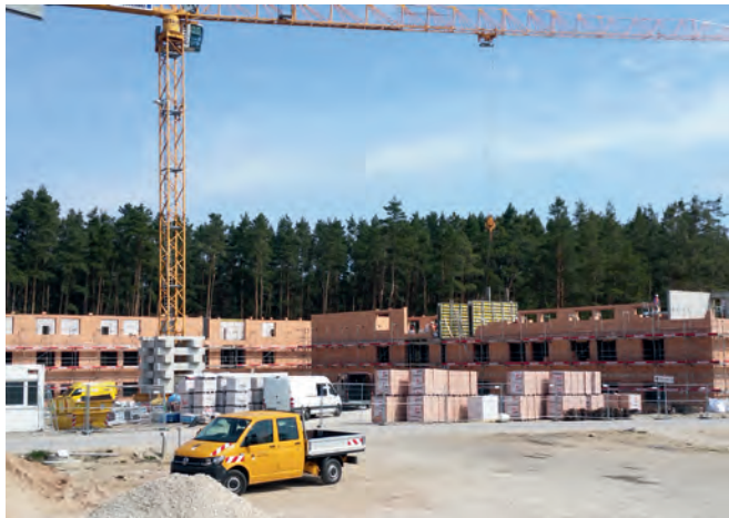
Neubau „Dreierhöfe“ nach Fertigstellung der Infrastruktur
