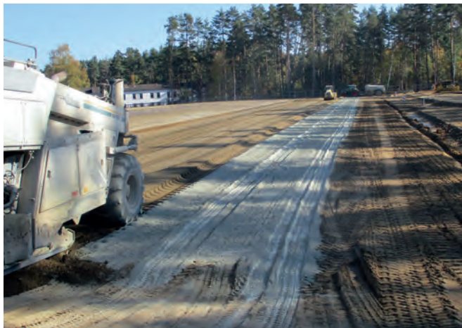
Verfestigung des großen Exerzierplatzes
