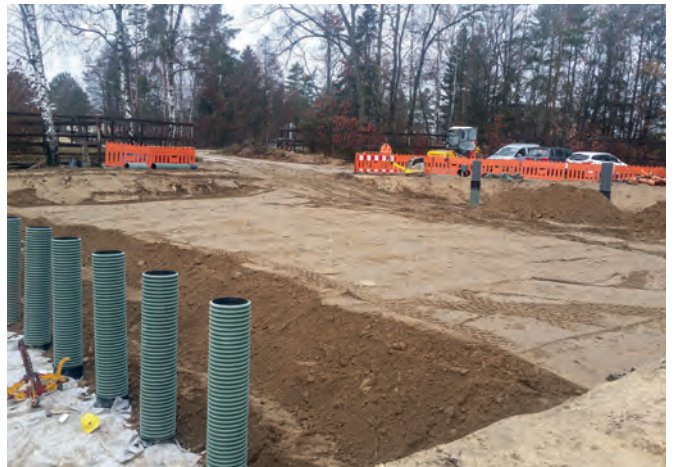
Versickerungsrigolenanlage
