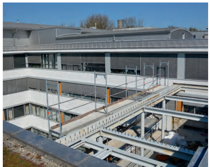
Der Innenhof im Rohbau
