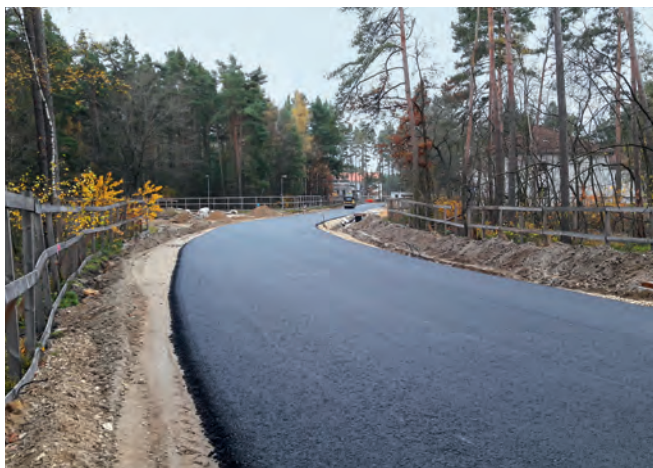
Künftige Wohnstraße als Baustraße
