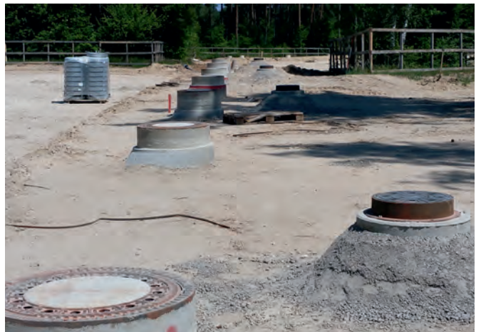
Schmutzwasser- und Rigolenschächte umranden die „Dreierhöfe“
