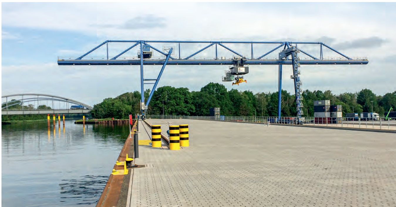
Containerladekran in der Erprobungsphase
