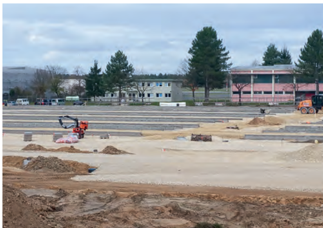
Hauptparkplatz im Bau
