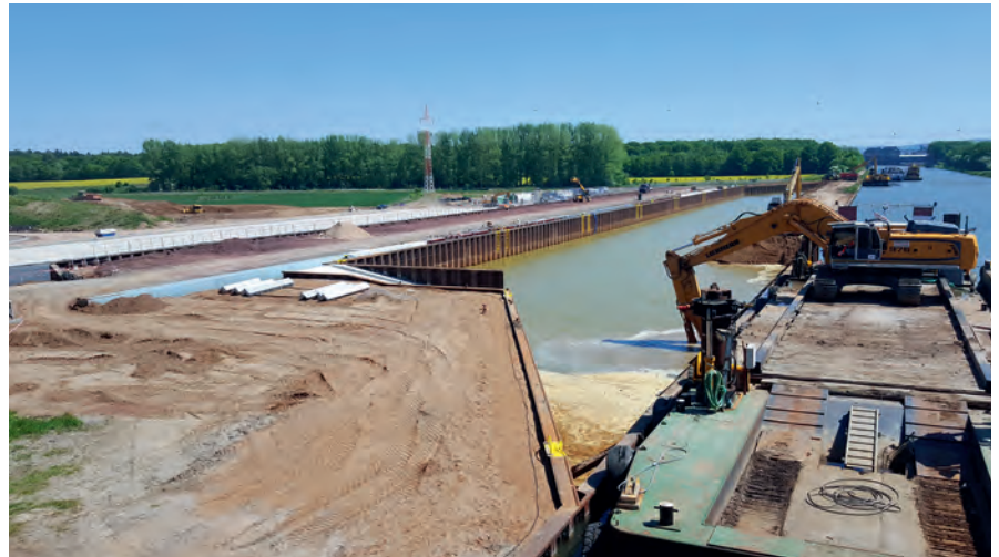
Wegbaggern des alten Kanalseitendamms
