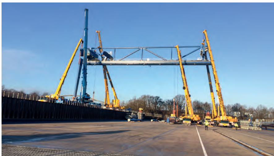
Sieben Mobilkräne waren zum Aufrichten nötig
