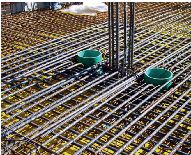
Bewehrung und Regelaussparung bei Innenstützen
