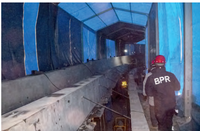
Eingehauster Betonierabschnitt
