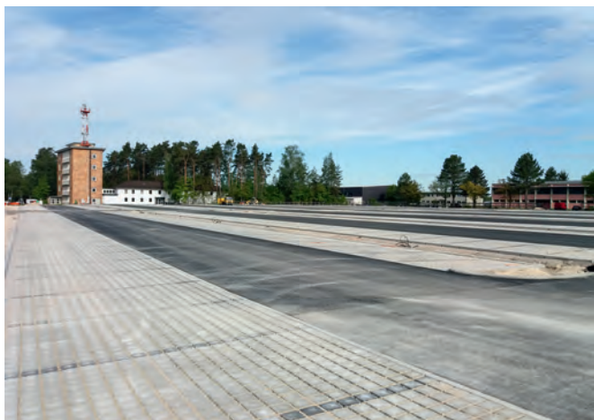
Fast fertiggestellter Hauptparkplatz
