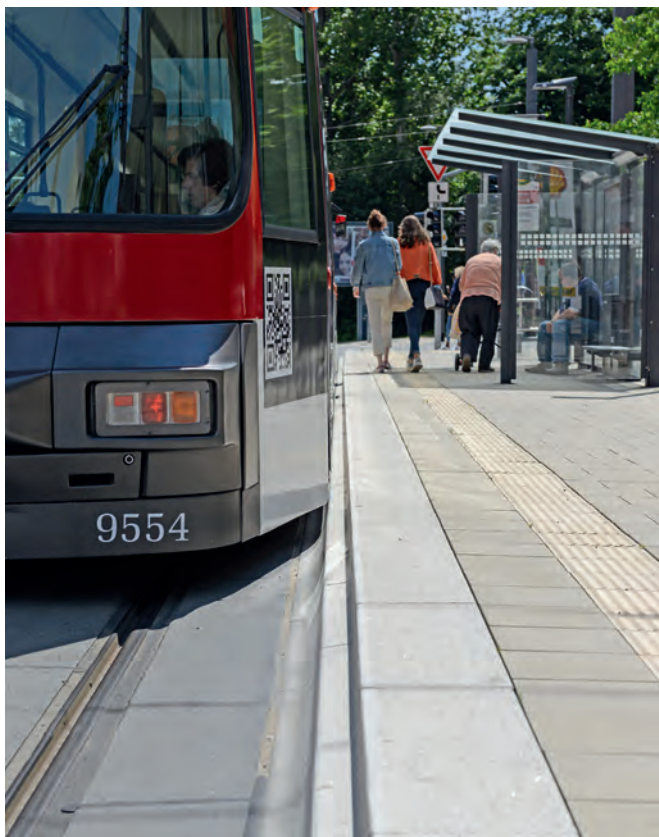
5: Sonderbord Bus/Bahn für die verbesserte Barrierefreiheit
