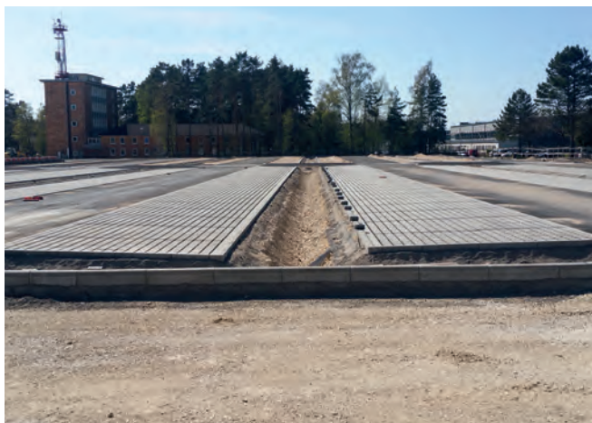
Parkflächen mit Versickerungsmulden
