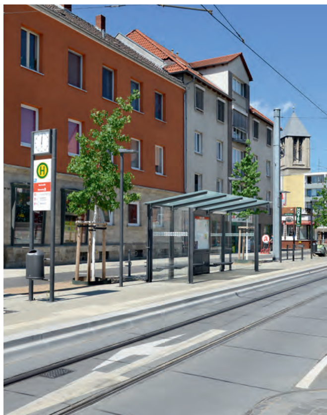
8: Verlegte Haltestelle Marienstift
