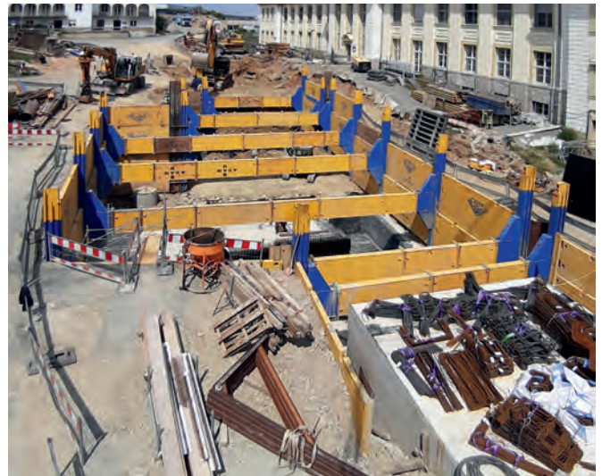
Baustelle Versorgungskanal 2/3 aus Sicht des Kranführers
