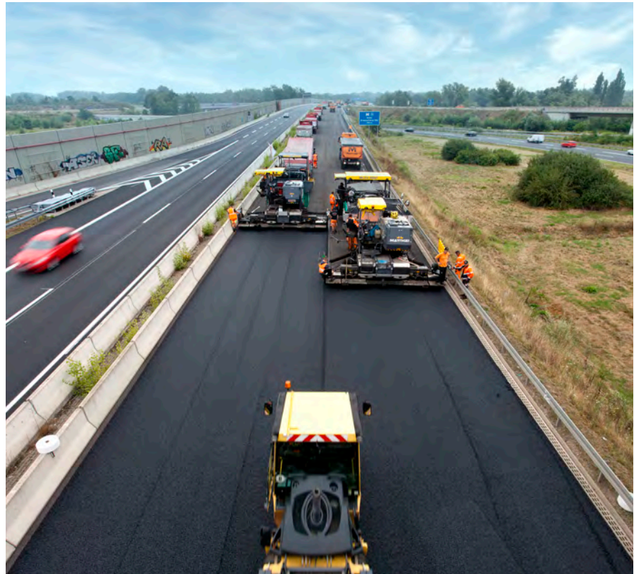
Logistik des Einbaus
