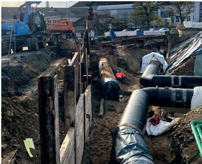
Maßnahme Medientunnel, Verlegung Mehrleiterrohr
