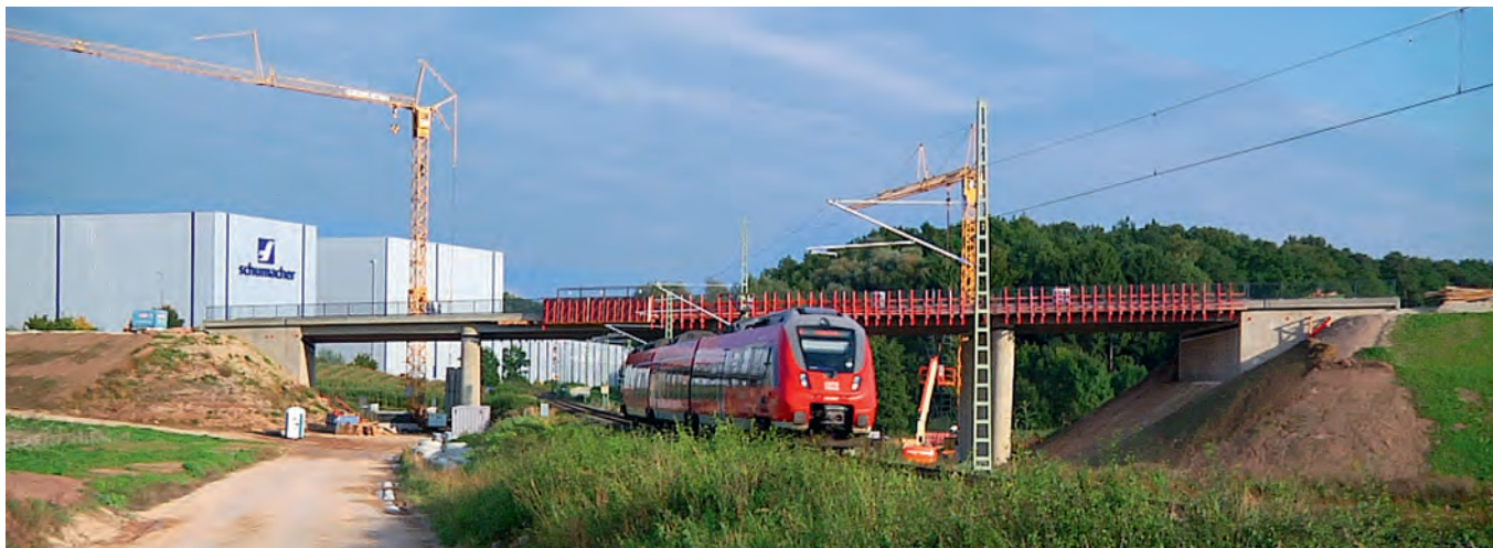
Straßenüberführung im Bau
