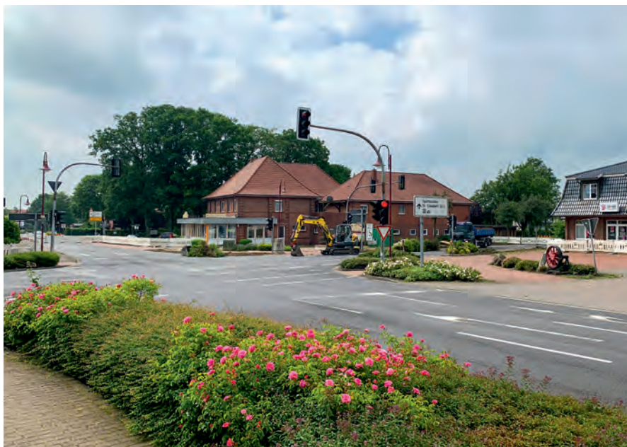
Die Kreuzung Linderner Straße/Vlämische Straße im Bestand
