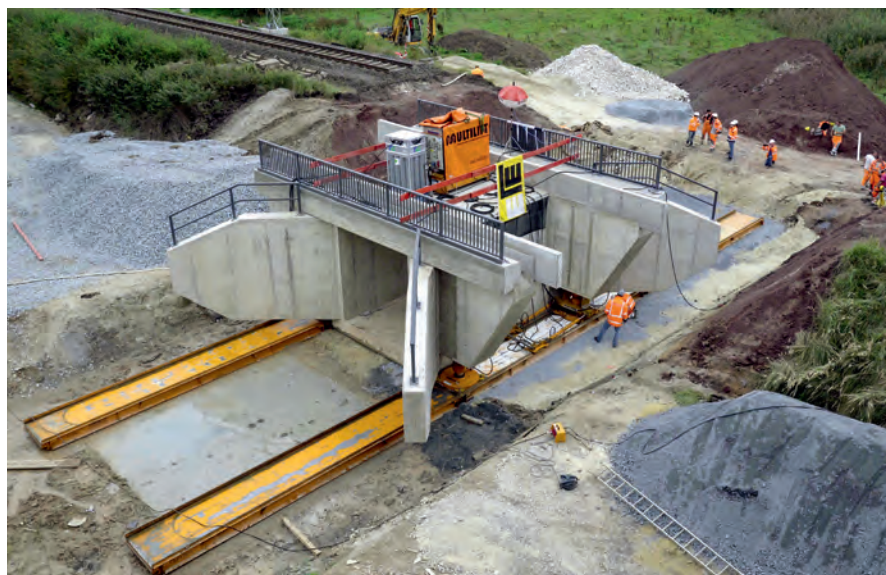
Einschub der Eisenbahnüberführung
