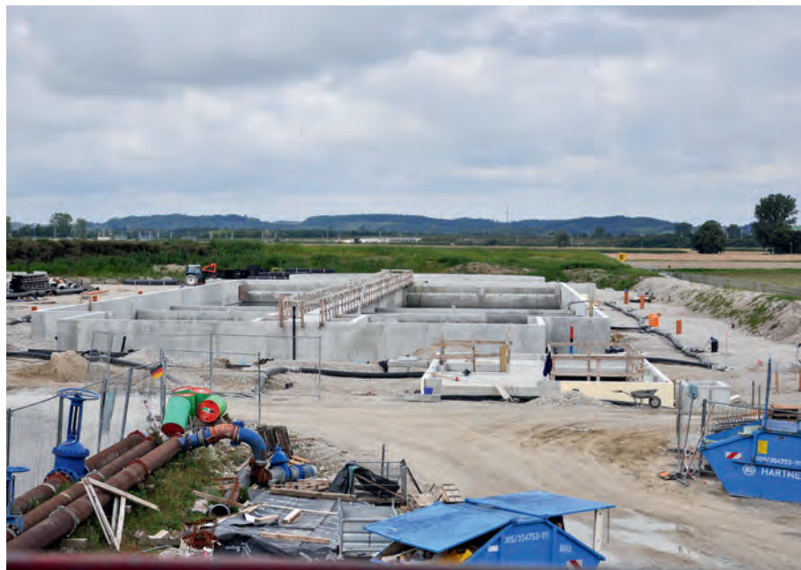
Baufortschritt Belebungsbecken mit ca. 10.000 m 3
