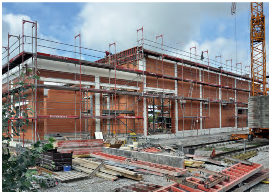
Baufortschritt Energie- und Maschinengebäude
