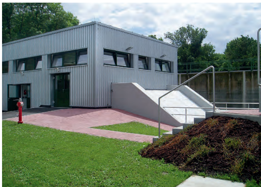
UV-Desinfektionsanlage mit Schneckenhebewerk
